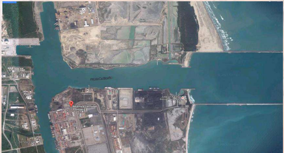
Figura No. 2.3 Puerto de Altamira
